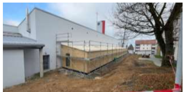
Rohbau des Umkleidebereichs
