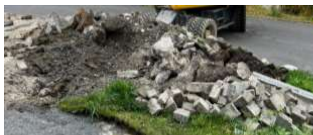
Viel Beton war verbaut
