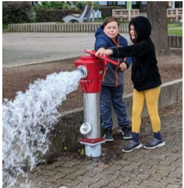
Hydrant in Betrieb nehmen
