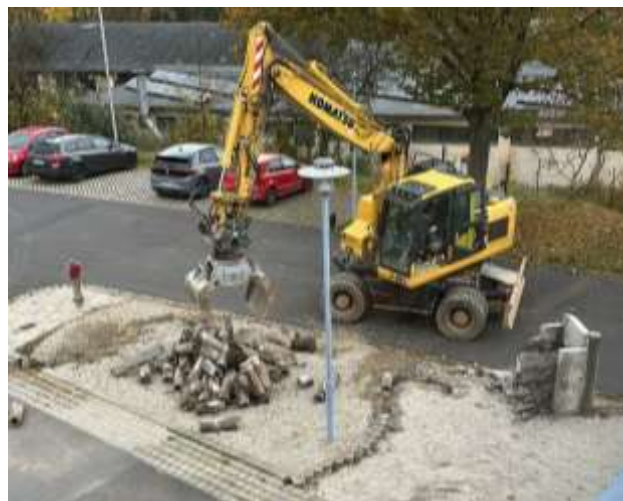
Abbruch der Betonteile des Spielplatzes
