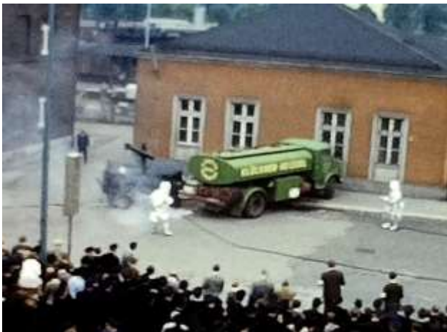
Film: Übung am Bahnhofplatz, Brandbekämpfung mit Hitzeschutzanzügen, 1967
