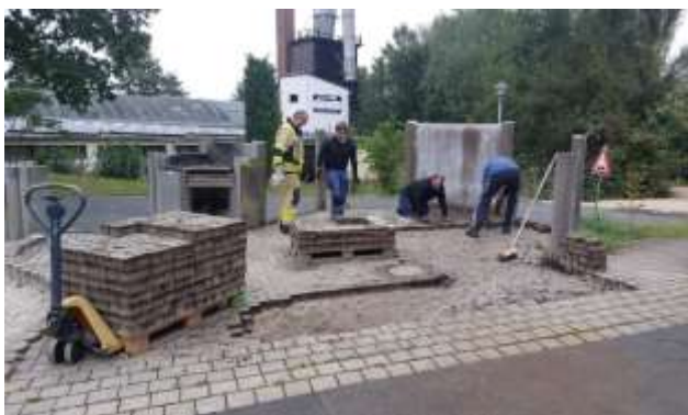
Ausbau des Steinpflasters
