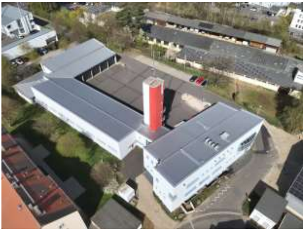
Feuerwehrhaus vor Umbaumaßnahmen
