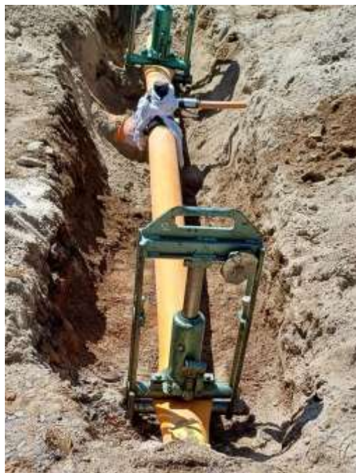
beschädigte Erdgasleitung
